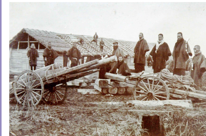
柳原小学校移転工事
