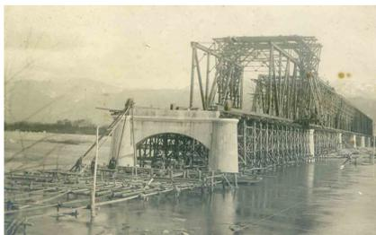
旧村山橋建設時の鉄鋼組立工事。鉄は米国のカーネギー鉄鋼株製を使った
