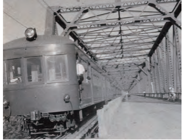
昭和31年7月21日 村山橋 長野電鉄
