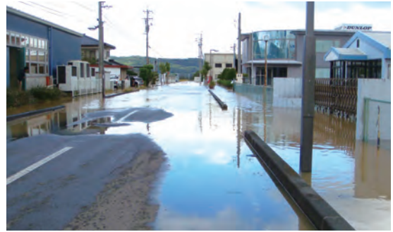
道路も冠水 柳原下返町（消防署付近）
