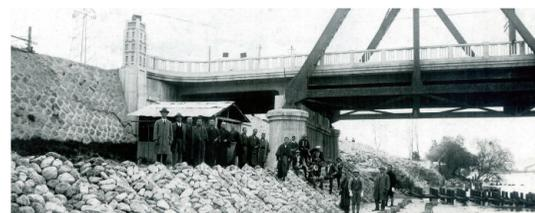
前の橋の写真（昭和初期）。村山橋の護岸工事千曲川左岸の北八幡川暗から村山橋間は流れの中心が堤防に接近し、川底も深く常に崩壊の危険があった。完成した工事を私服の役人が視察している。杭を打ち、詰め石を敷き、地固めをして護岸に蛇籠を並べている。村山の役員も写っている。
